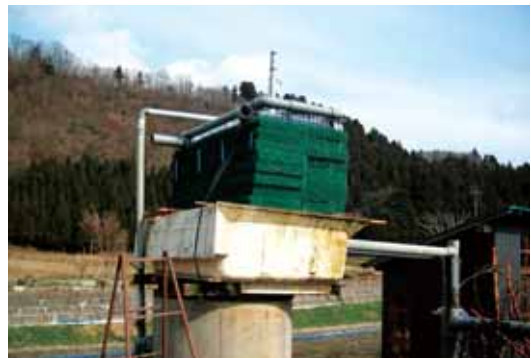
写真3 変更後の曝気(ばっき)装置
